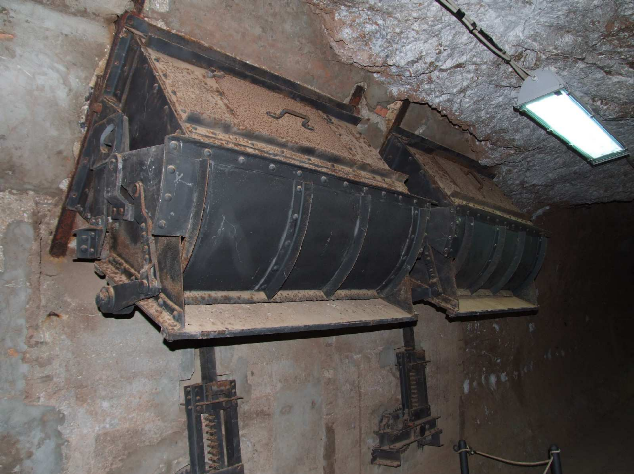
Immagine 3e: Rilievo fotografico dei materiali presenti all'interno dei siti minerari
